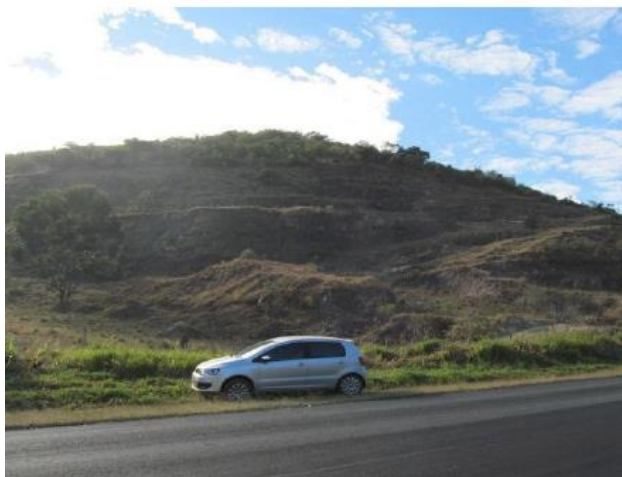
Foto 3 - Escavação em talude localizada na rodovia Aziz Lian (SP-107).
